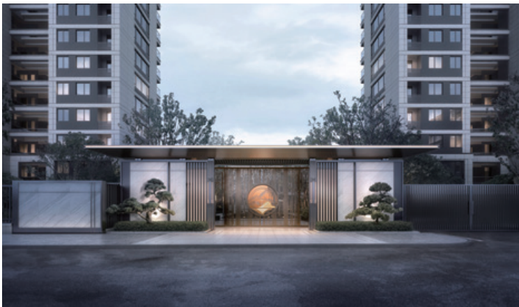
Hangzhou • Chuyue Mansion 杭州 • 漣玥府
